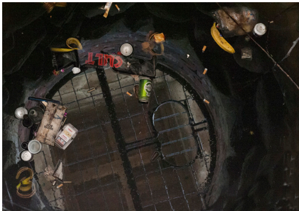
Et kig ned i brønden i juni 2012.
